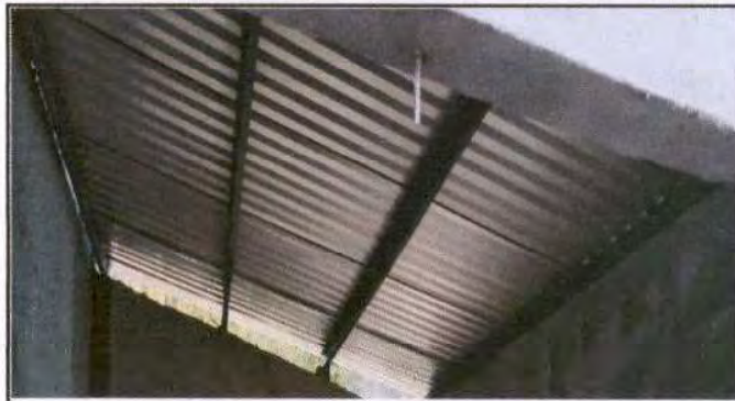
Foto 2: Se dará mantenimiento a las costaneras lo cual consiste en lijado y pintado. Cantidad de metros 24 m 2 .
