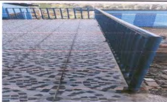
Foto 24: Sustitución de barandal de metal, por motivo que el material ferroso está picado en un porcentaje considerable. Cantidad de metros 8m²
