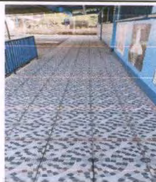
Foto 22: Colocación de piso cerámico antideslizante, debido al deterioro del piso liso, por sus años de construcción. Total de metros 44 m²
