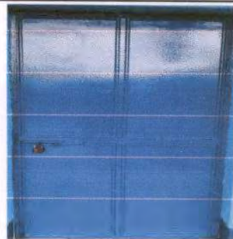
Foto 18: Reparación y mantenimiento de puerta de aula 3, por cuestiones de colocación de piso se tendrá que modificar. Medida de puerta 2m de altura por 1 de ancho.
