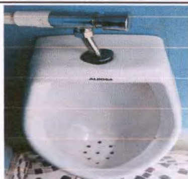
Foto 28: Instalación de mingitorio, para que los estudiantes ya no orinen en este espacio y cause malos olores.
