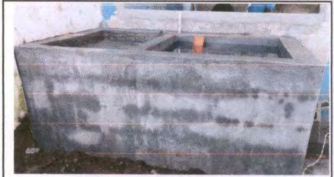
Foto 8: Sustitución de pila de cemento de un lavadero, por motivo de fuga de agua y liberar el espacio, se construirá en la parte de afuera como lo indica la imagen del lado derecho. Medidas 2 m largo por 1.20 de ancho y 0.80 m de alto.
