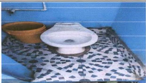
Foto 27: Colocación de piso cerámico antideslizante en los 4 espacios que conforman el módulo de baños debido al deterioro del piso liso. Total de metros 6 m².
