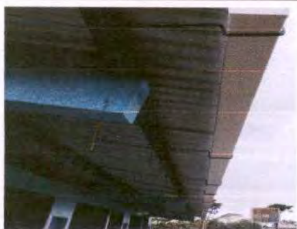
Foto 23: Colocación de canales de metal y bajada de agua pluvial, se hará con el propósito que en su momento pueda hacerse un tanque de concreto para guarda el agua. Total de metros lineales 24 y una bajada de
