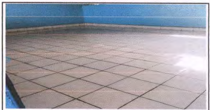
Foto 12: En aula 1 se colocará piso cerámico debido al deterioro del piso liso. Total de metros 51.5 m².
