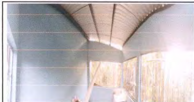
Foto 6: Pintura en paredes interiores y exteriores de la cocina, cantidad de metros 32 m 2
