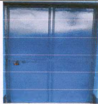
Foto 14: Reparación y mantenimiento de puerta de aula 2, por cuestiones de colocación de piso se tendrá que modificar. Medida de puerta 2m de altura por 1 de ancho.
