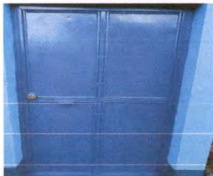
Foto 3: Cambio de puerta de la cocina escolar por deterioro en su estructura. Medidas de la puerta, 1.90 m de altura por 0.90 m de ancho.
