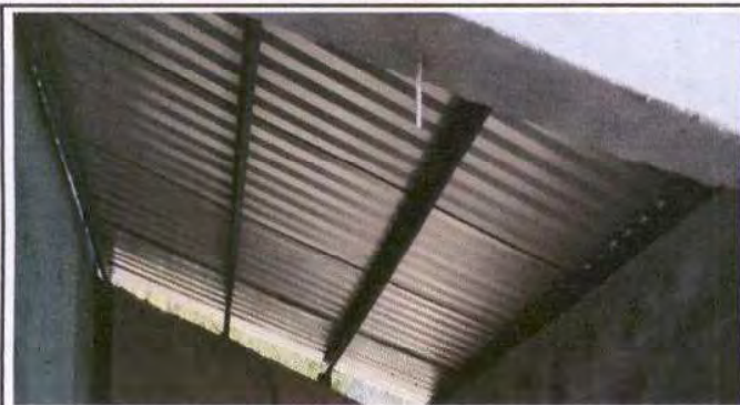
Foto 1: Cambio de techo por deterioro de las láminas , cantidad de metros 24 m 2 .
